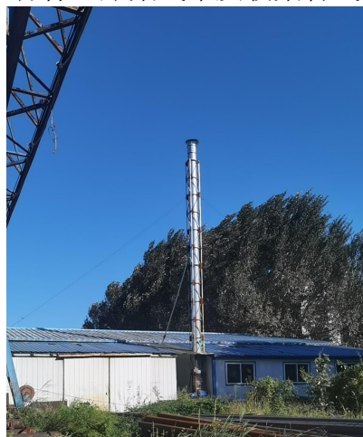
产污节点：打样；排气筒编号：DA003； 排气筒高度：15m
