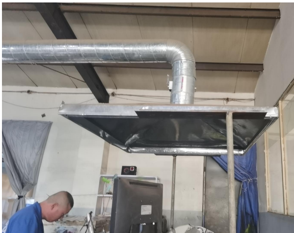
打样工序集气罩及收集管线
