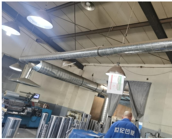
打样工序集气罩及收集管线
