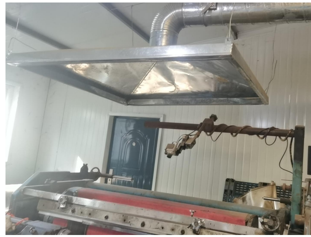
打样工序集气罩及收集管线
