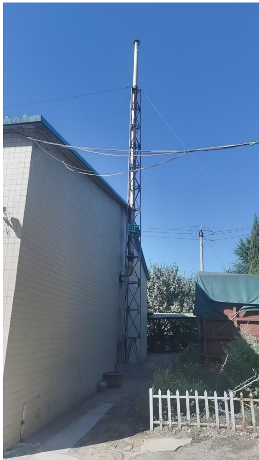
产污节点：镀铜工序 排气筒编号：DA001 排气筒高度：15m
