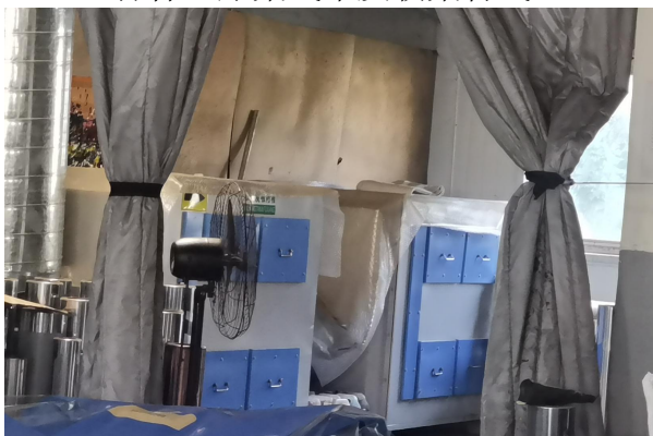
打样工序集气罩及收集管线
