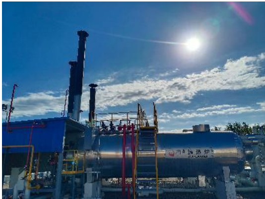
加热炉8m排气筒
