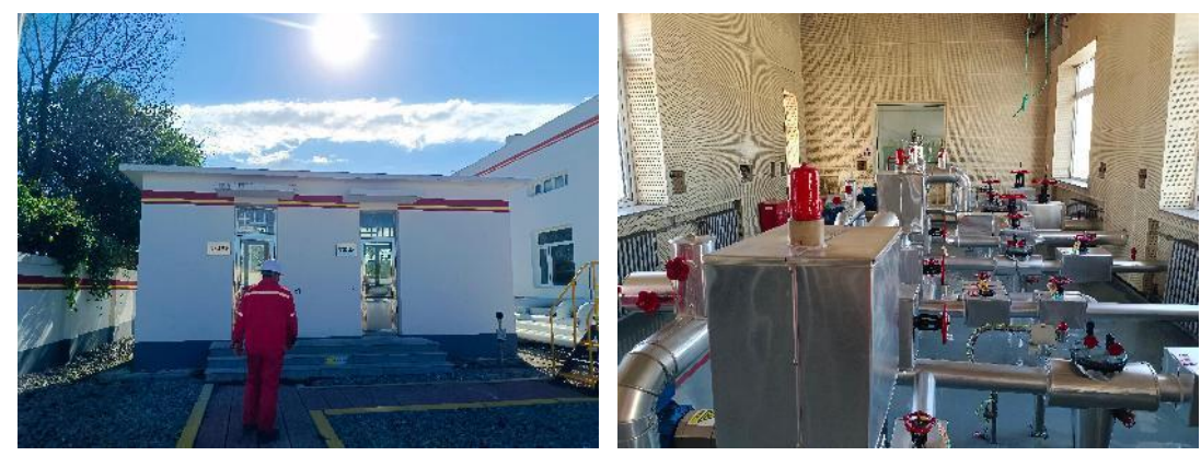
泵房隔声减振
