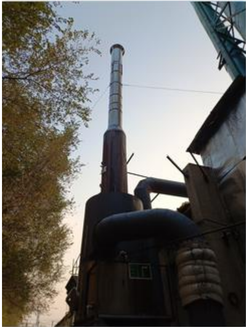
干燥工序及燃气干燥炉排气筒（DA002）
