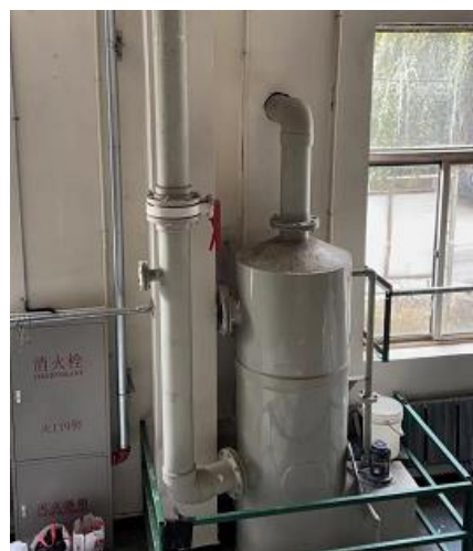
后处理釜废气收集装置
