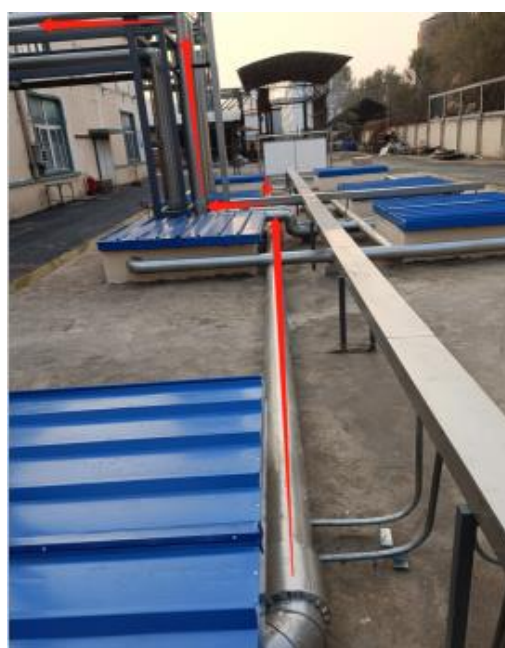
丙烯酸储罐废气收集管线
