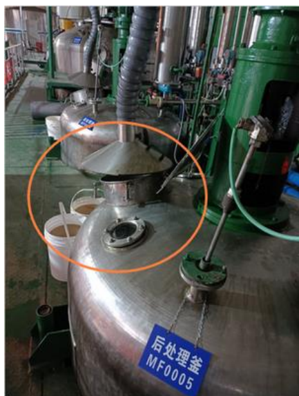
后处理釜废气收集装置
