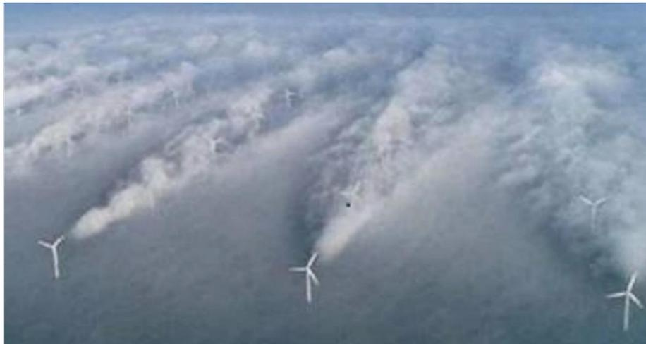
上图为丹麦 Horns Rev 海上风电场的尾流干扰图。从上图中可以清晰看到上游风力发电机组会对下游机组的运行产生影响。当自然风吹过风力发电机组时，风机会吸取风的部分能量使其速度降低，速度降低的同时风的湍流强度会有所增加，下游风力发电机组就会因此受到影响。尾流效应造成的能量损失对风电场的经济性有着重要的影响，当风力发电机组完全处在尾流区域运行时，功率损失可达 30%到 40%。
